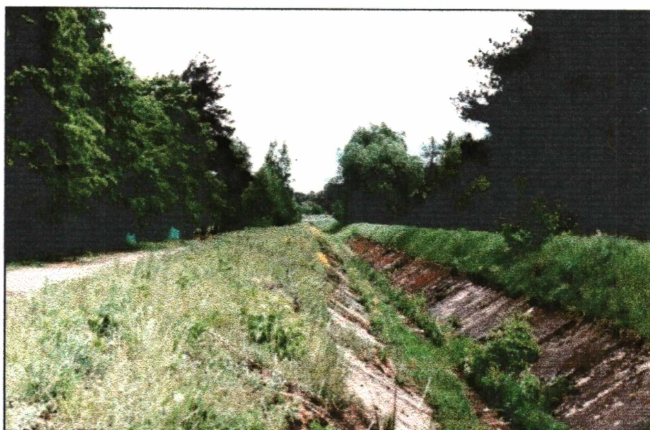
FOT.12 Doprowadzalnik główny zasilający w wodę obiekt melioracyjny „Bagno Wizna” -Chlebotki Nowe 2001r.
